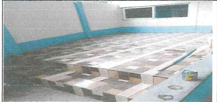
REPARACION DE ESCENARIO
