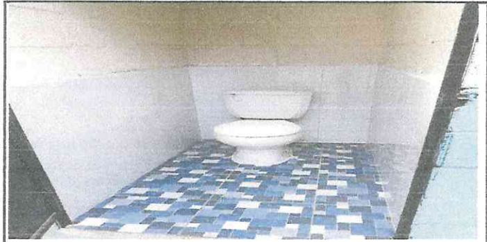
INSTALACIÓN DE PISO CERAMICO Y ASULEJO EN EL AREA DE LOS SANITARIOS
