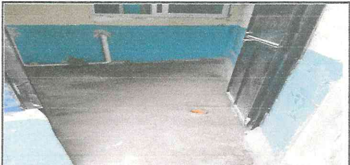
REPARACION DE PISO CONCRETO E INSTACION DE LA PUERTA DE METAL
