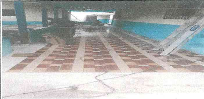
INSTALACIÓN DE PISO CERAMICO EN EL AREA DEL CORREDOR
