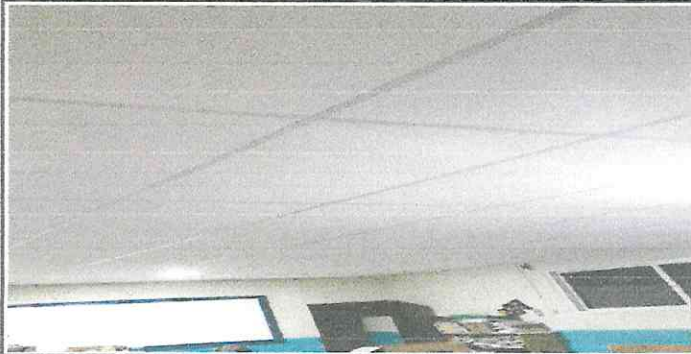
INSTALACIÓN DE CIELO FALSO
