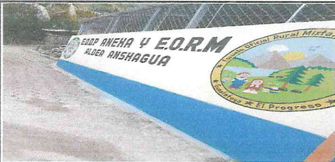
REPARACIÓN DE PINTURA Y LOGO DEL ESTABLECIMIENTO
