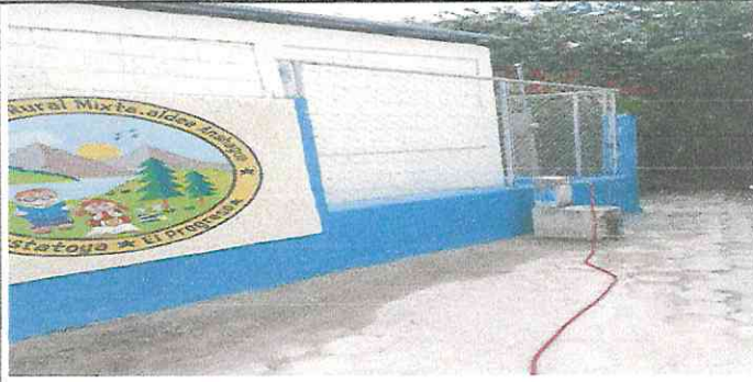
REPARACION DE MALLA EN EL MURO PERIMETRAL
