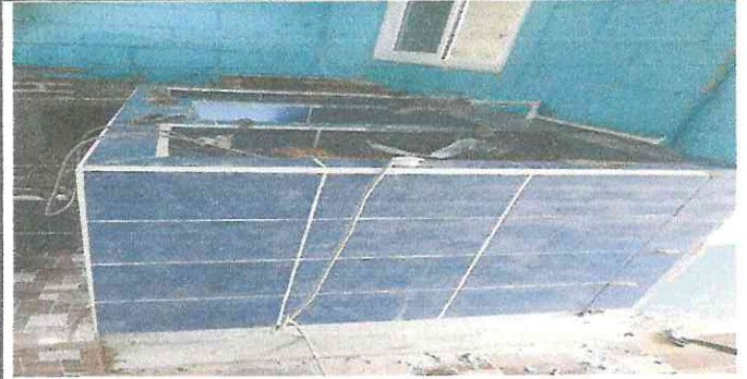
INSTALACION DE ASULEJO EN LA PILA DEL AREA DE A COCINA E INSTACION DE VENTANA DE PVC
